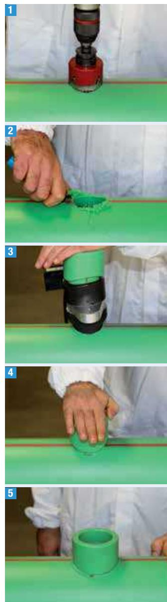
Con l'apposita fresa praticare il foro nel tubo in PP-R verificandone la perpendicolarità.
