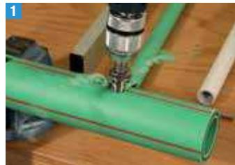
Con l'apposita fresa praticare il foro nel tubo in PP-R verificandone la perpendicolarità.
