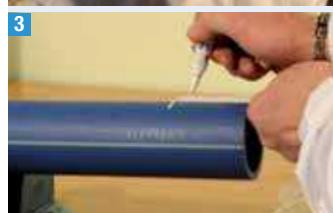
Aggiungere 1 cm alla misura rilevata per ottenere la parte della testata del tubo da raschiare: segnare la misura servendosi di un apposito marcatore.
