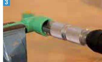
Attendere il raffreddamento del raccordo dopodiché, con la fresa art. 50128 montata su trapano, calibrare la sede di saldatura.
